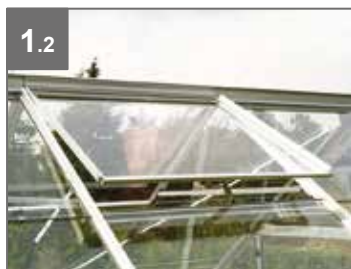
1.2 Lucarne Vue extérieure
