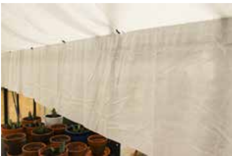
Système d'ombrage Beschattungssystem Shading system
