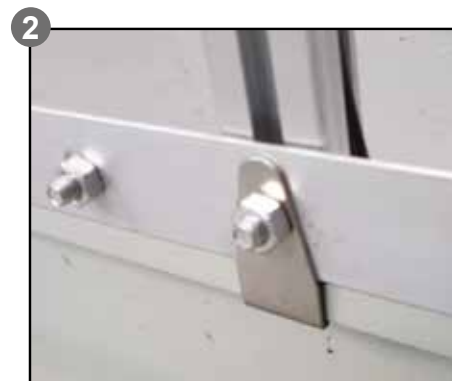
Crochet à positionner Haken anbringen Attach hook
