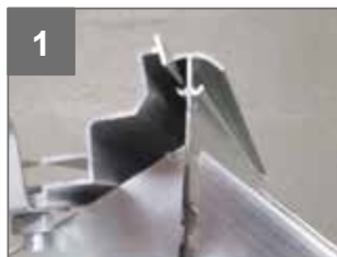
Pose de la lucarne sur faîtière par glissement. Anbringung des Fensters auf First durch Gleiten. Installing the window on roof ridge through sliding.
