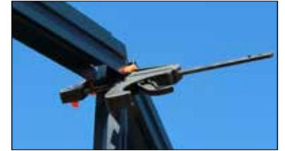
Positionnez en attente la vis tête marteau et l'écrou (42 et 43) sans les serrer afin de glisser la tête de la vis marteau dans les fentes de la faîtière.
