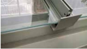
Vis M6x12 (42) au niveau des profilés sans tirant de toiture
